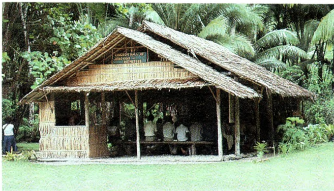
La Salle du Royaume de Gizo, dans la province occidentale. Certaines salles sont construites avec du bois tiré de la brousse et des feuilles de palmier entrelacées ou cousues.
